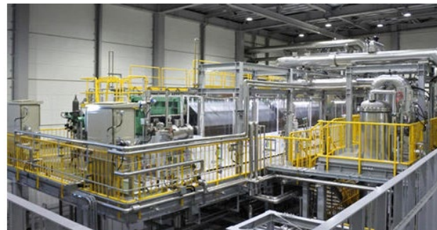
10MWの水電解装置
