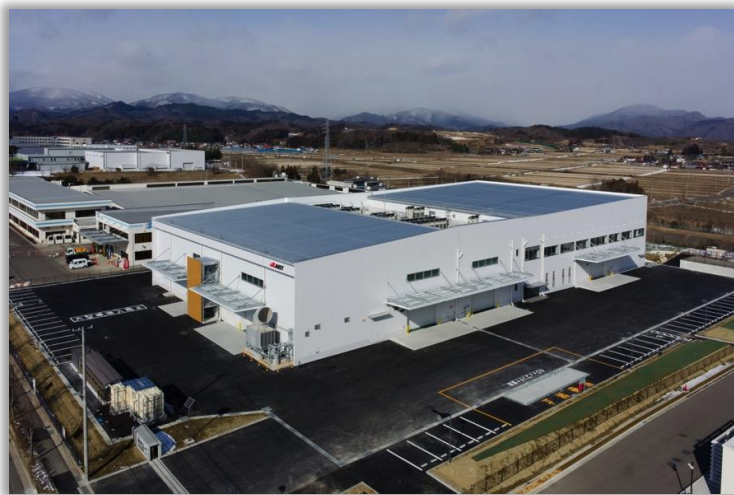
スマートシステム研究棟 MW級で世界の電力条件を再現可能 (各種分散型調整力の評価が可能)
