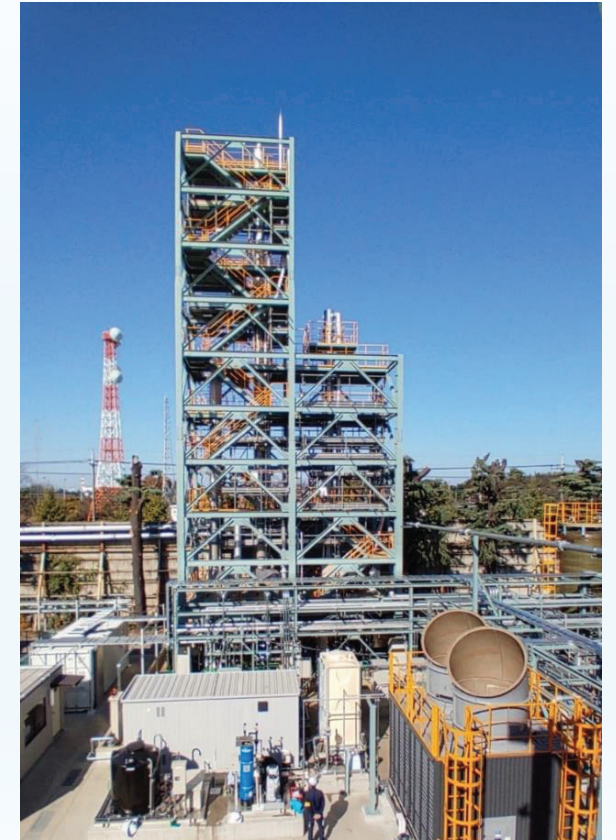
設備サイズ：600m 2 、25mH
