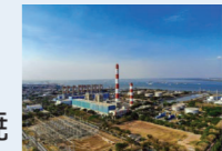
グレシクガス火力発電所
