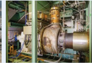
IHI製2MW級ガスタービン
