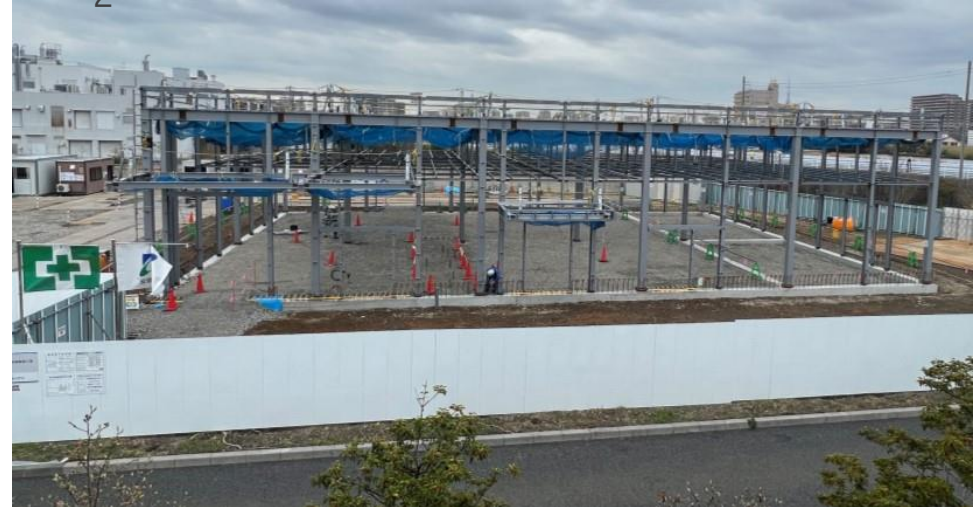
CO 2 to DPCベンチプラント建築現場(2022年末)
