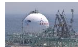
液化水素タンク
