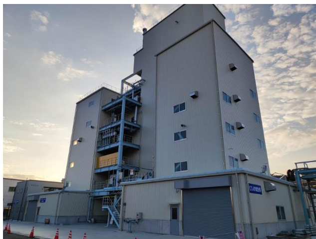
革新的セメント製造プロセス (C2SPキルン® 実験機、山口県)
