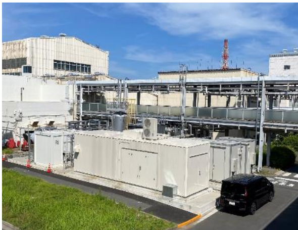
CO 2 フリー水素製造 (水電解設備)
