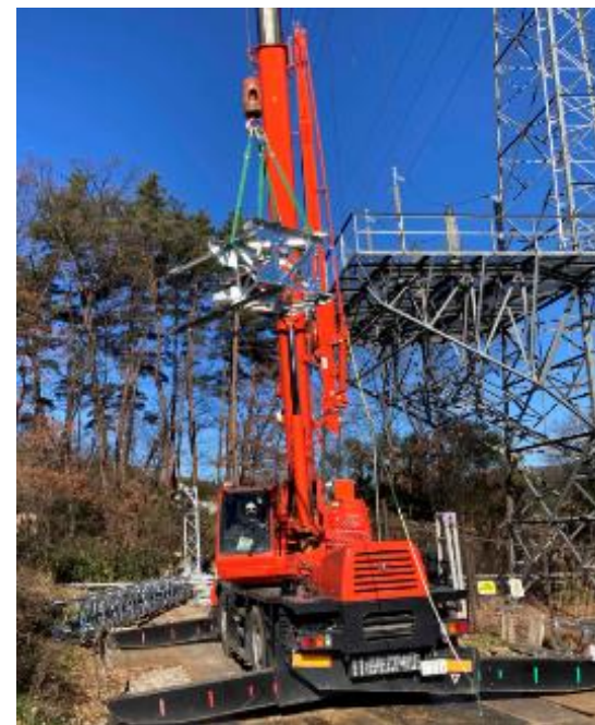
連系碍子架台組立作業
