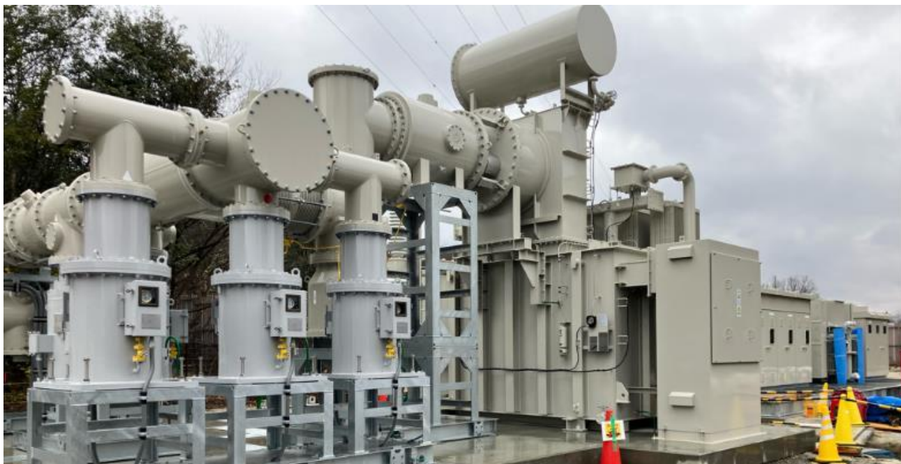
特高設備の設置完了
