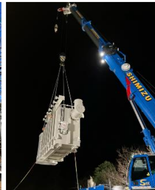
サントリー来場者に配慮した 夜間のTr設置作業
