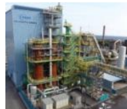
12m 3 小規模試験高炉（水素還元） （出典）経産省「グリーン鉄研究会」
