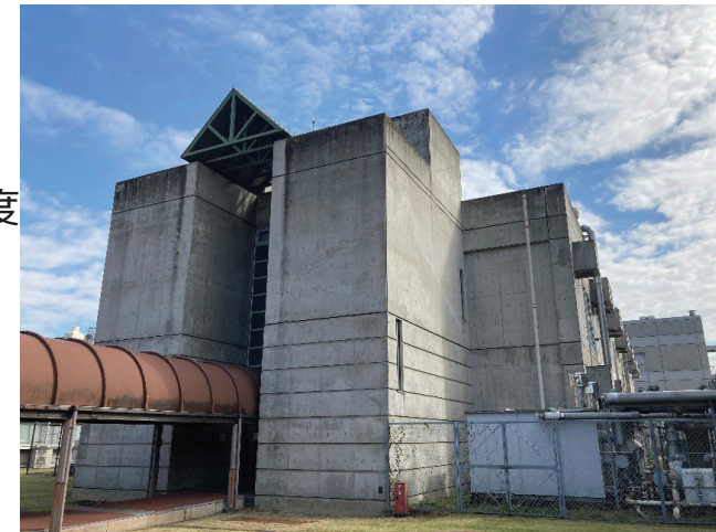
本プロジェクトで活用する建物
