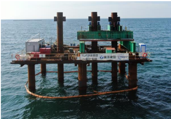
石狩湾で実施した国内初となる繰返し荷重を用いた杭の引抜き実験 (提供：東洋建設株式会社)
