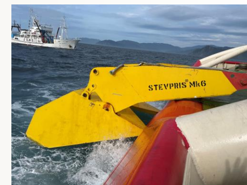
アンカー投入状況
