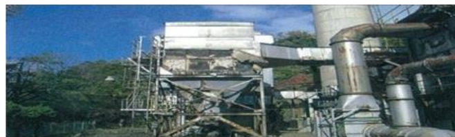
老朽化して休止した処理施設
