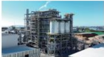
広畑バイオマス発電所
