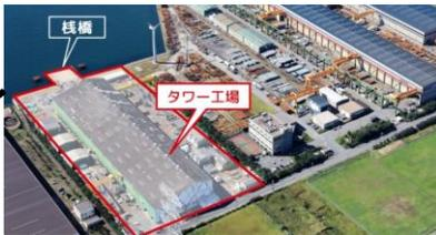
国内初の洋上風車用タワー生産ライン。国産高張力鋼材の利用による軽量化を狙う。2029年に年間約30基の製造能力を整備。
