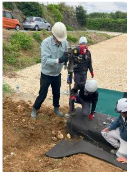
耐風性向上の為の特殊アンカーによる設置状況
