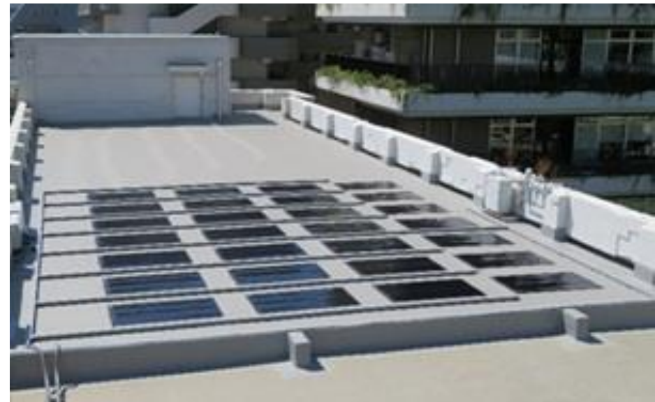
FGNに設置された防水材一体型ペロブスカイト太陽電池
