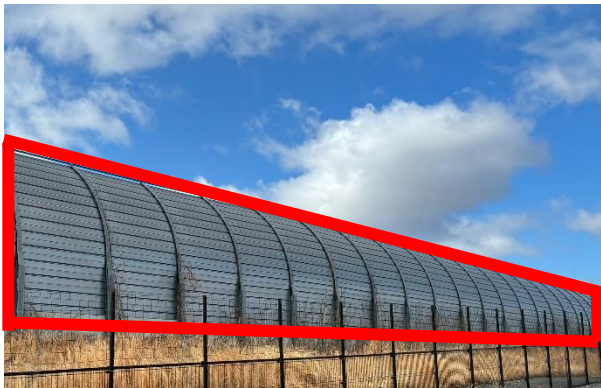
高速道路内の遮音壁の例（外壁）
