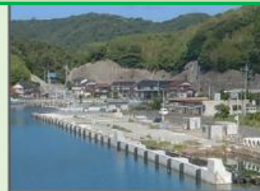
災害発生時の物資輸送拠点となる 耐震強化岸壁の整備
