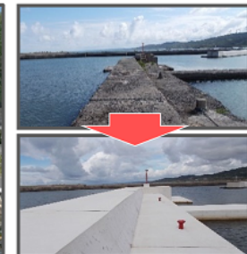
漁港施設の長寿命化対策
