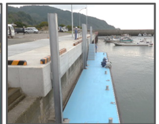
陸揚げの軽劣化に資する 浮体式係船岸の整備
