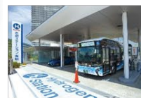
水素ステーション
