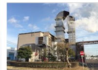
水素発電設備
