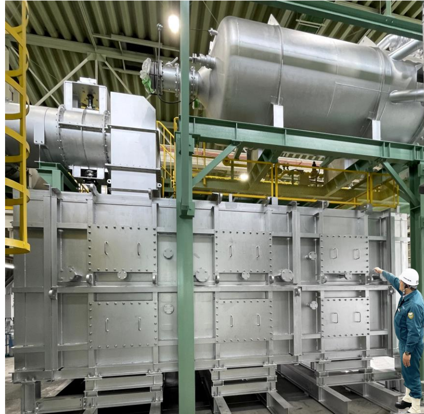
1.5MW 大型試験炉 (アンモニア燃烧式鉄鋼加熱炉の開発)
