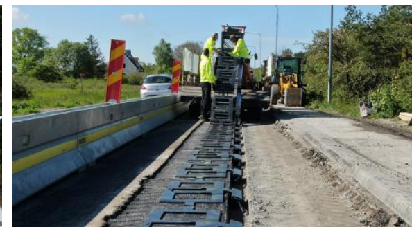
DWPT送電コイル（道路側）の埋設風景
