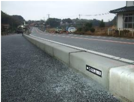
道路ブロック
