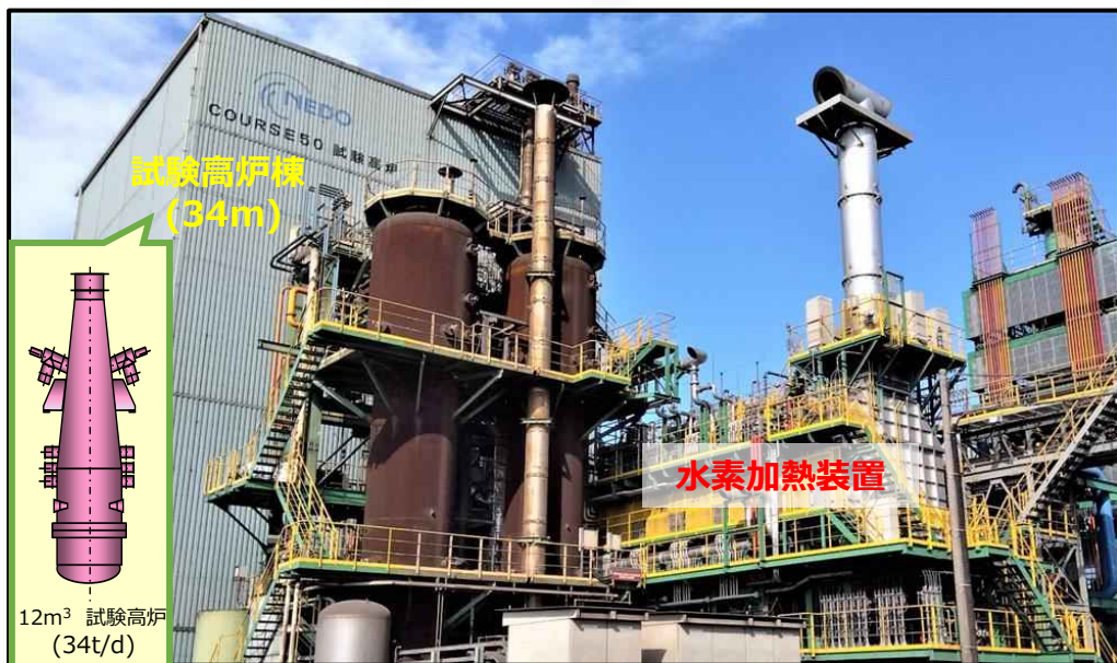
水素還元試験高炉（12m 3 ）の外観
