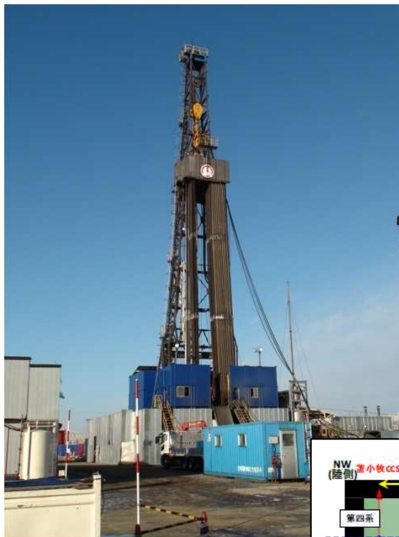
リグ(掘削機械) 高さ:48.50m
