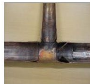
銅管を縦割り
