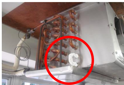
霜の付着（通常冷えるべきでない場所で凍結や結露がある）
