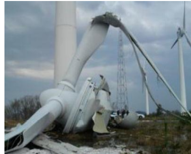
【京都府】太鼓山風力発電事故状況
