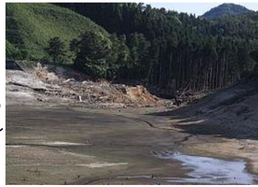
【決壊した藤沼ダム】 堤高18m、堤長133mのダムが地震直後に決壊し約150万tの水が流出(7名死亡、1名行方不明)
