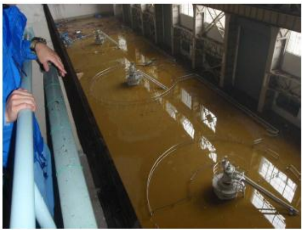
④ 上田発電所 発電機浸水状況 (7/30)
