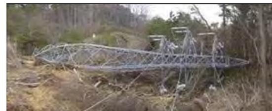
盛土の崩壊原因は、沢を埋めた盛土中の地下水位が存在する状況において、強くて長い地震動の繰り返し応力が作用したことにより、地盤強度が低下したものと推定
