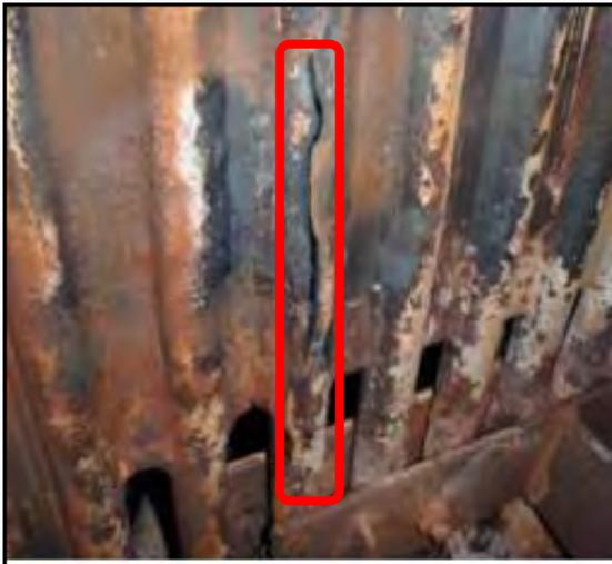
(写真1)ボイラーチューブの破孔
