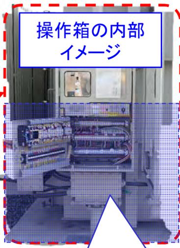
電気回路が、水没レベルにあるため、使用不可と判断
