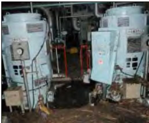
(写真1) 復水ポンプ(電動機)の被害
