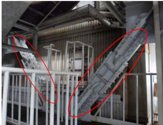
ボイラ支持架構の補強例
