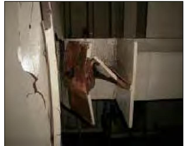
(写真3)ボイラー鉄骨の変形
