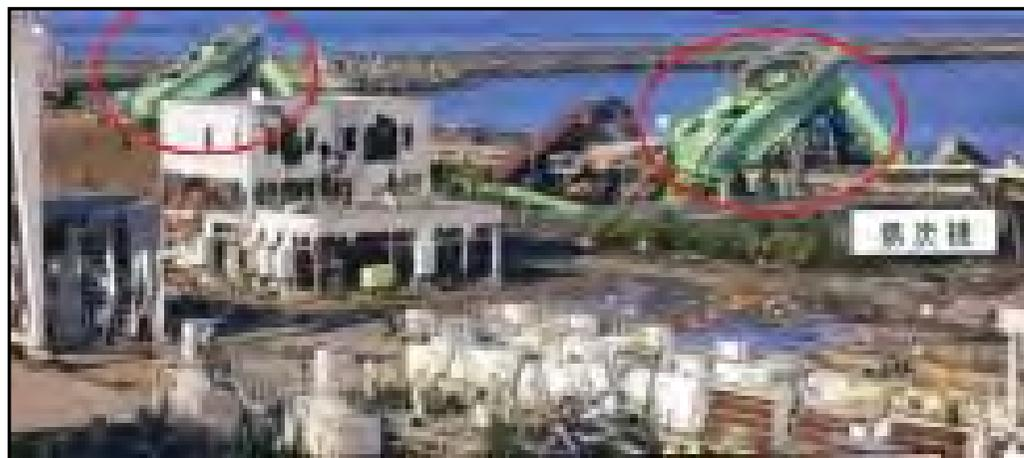
(写真4) 揚炭設備の被害
