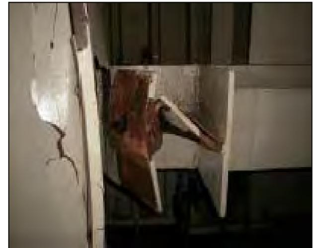
(写真3)ボイラー鉄骨の変形
