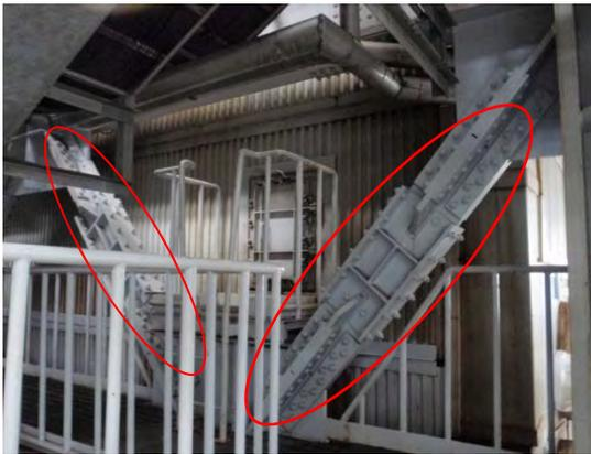
ボイラ支持架構の補強例
