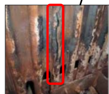
ボイラーチューブ の修理箇所
