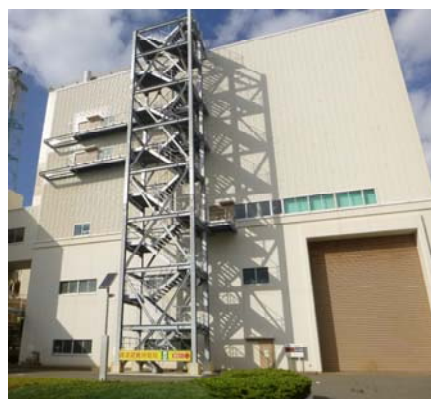
屋上への避難階段
