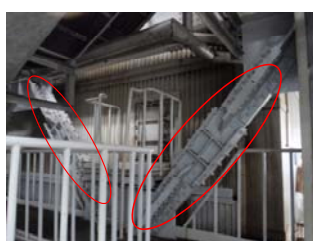
ボイラ支持架構の補強例
