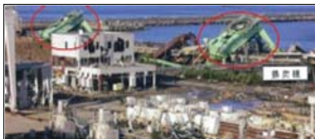
(写真4)揚炭設備の被害
