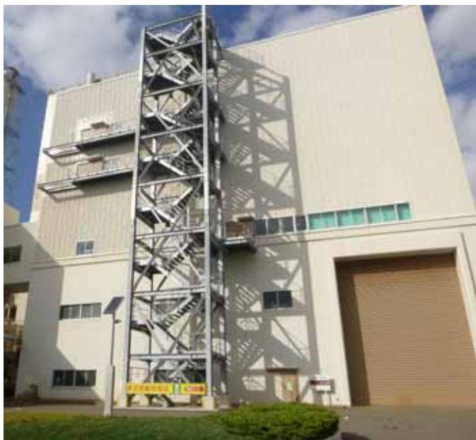
屋上への避難階段
