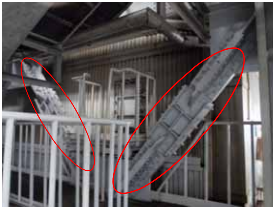
ボイラ支持架構の補強例
