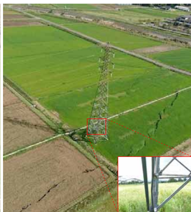
66kV黒川一の宮線№32
