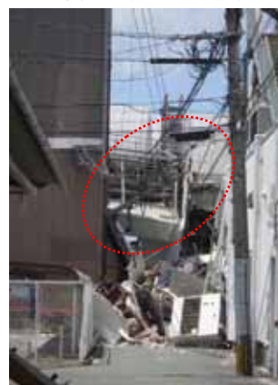
[熊本市内] 建物倒壊に伴う2次被害
