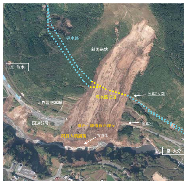
阿蘇大橋付近斜面崩壊状況(撮影:H28.4.20)
