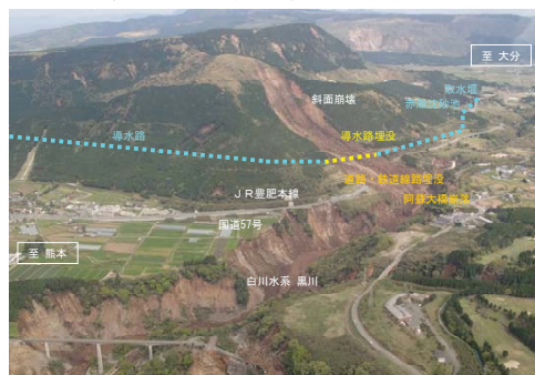
阿蘇大橋付近斜面崩壊状況(撮影:H28.4.16)
