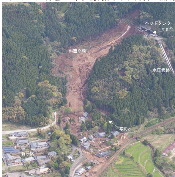
ヘッドタンク周辺斜面崩壊状況（撮影：H28.4.16 10:30）
