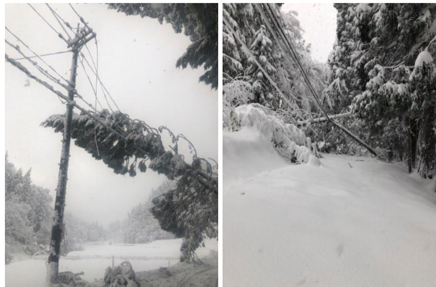
倒木による配電線及び支持物への損傷の他、立入困難箇所が複数箇所発生し、停電解消に時間を要した。
