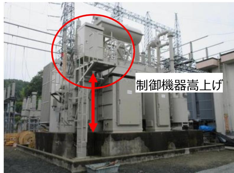
変圧器制御機器嵩上げ対策（中国電力）
