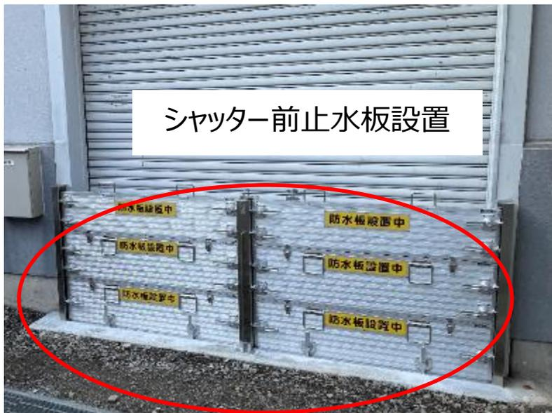
水力発電所建屋浸水対策（中部電力）
