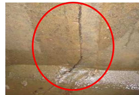
写真③ クラック状況（導水路内面）
