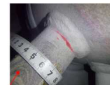
節炭器中間管寄せ節炭器管管台（#2）
