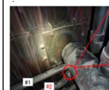
節炭器中間管寄せ管台（SH側-前側）
