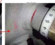
節炭器中間管寄せ節炭器管管台（#2）
