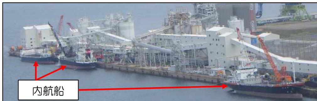
受入コンベアの損傷により石炭受入が出来なくなったことから、外航船から内航船へ積み替えて、両社で協力して石炭を受入。
