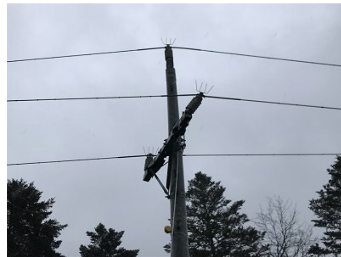
22kV陸別線No.211 碍子傾斜（陸別町）
