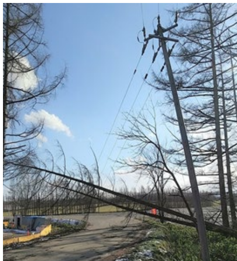
配電線への倒木（芽室町）
