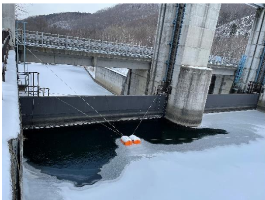
洪水吐ゲート前面 水中ミキサー設置状況
