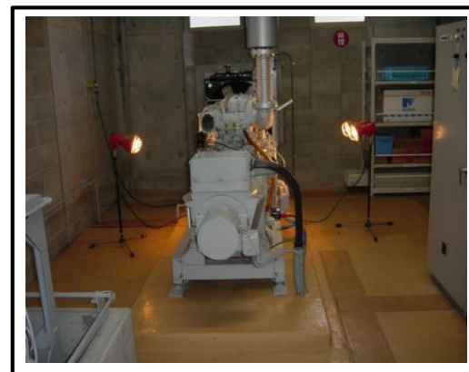
予備電源装置アイランプ設置状況
