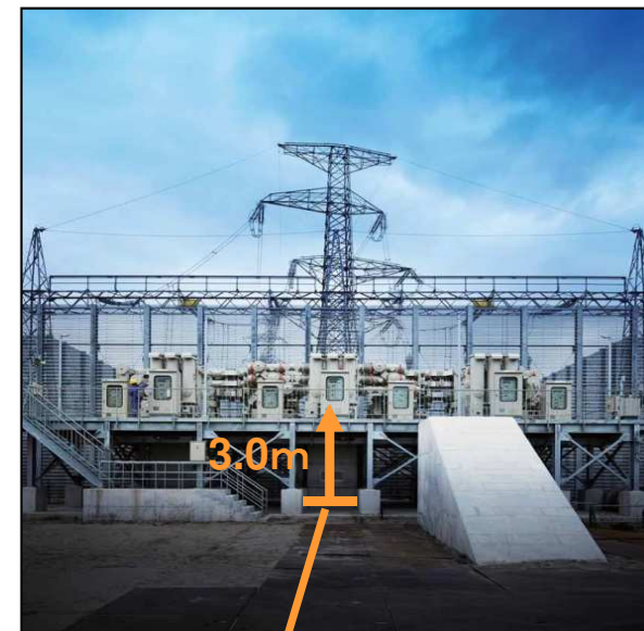
【写真2】屋外開閉所 設備を3.0m嵩上げ
