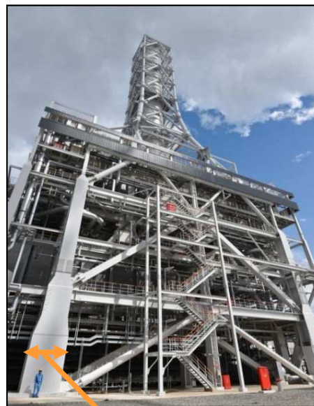
【写真1】排熱回収ボイラー 支持鉄骨の太さ2.6m
