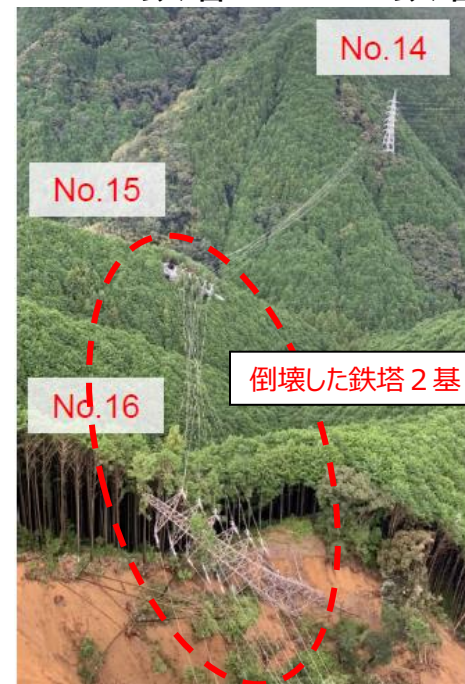
倒壊した鉄塔 No.15鉄塔～No.16鉄塔
