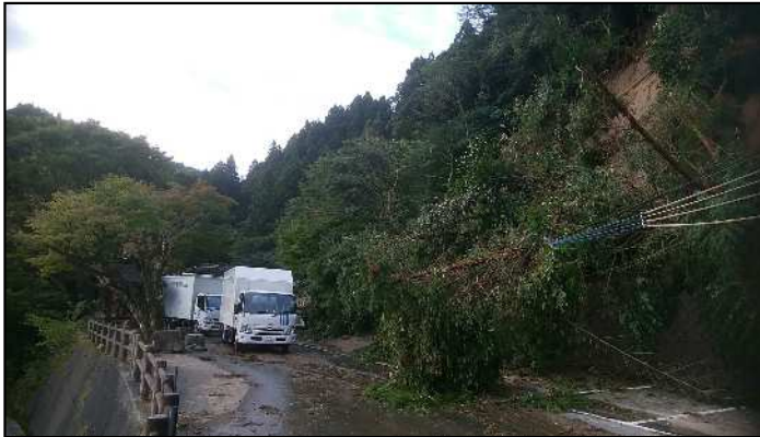
送電：電線断線（熊本県）
