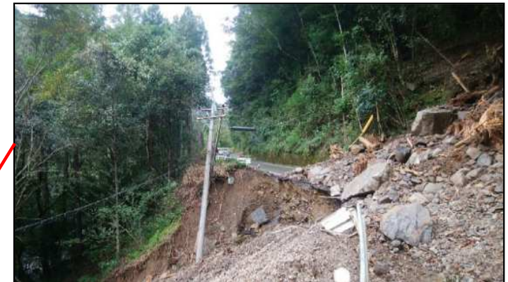
配電：支持物折損、電線断混線（鹿児島県）
