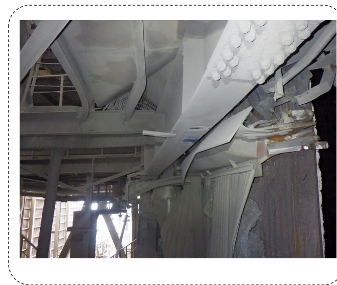
梁の変形状況(代表部)
