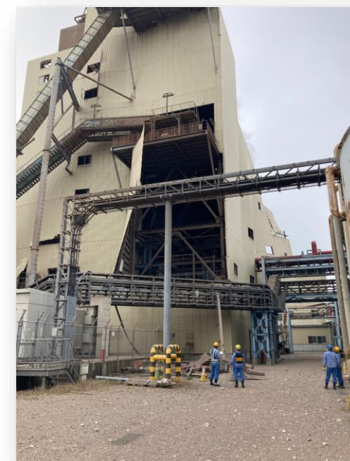
【破損状況写真】
