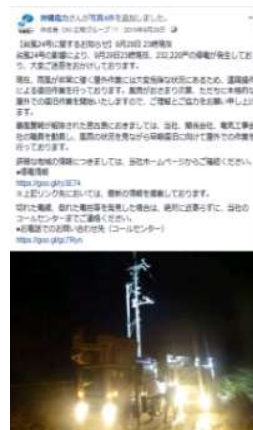
復旧作業の様子
