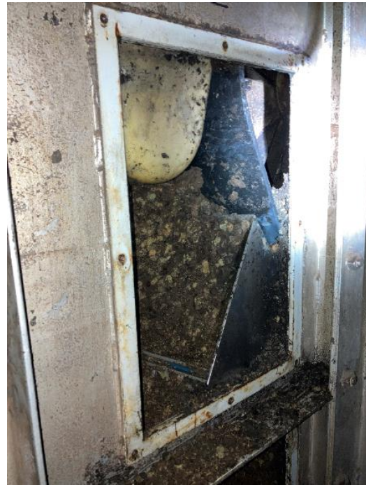
点検窓からの様子
