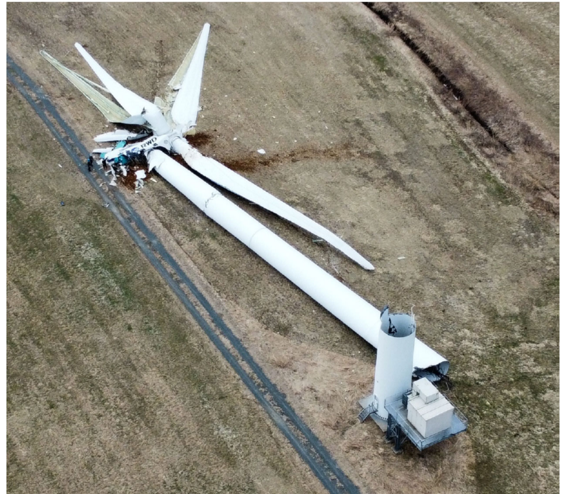
図1-4. 事故時の上空からの状況写真
