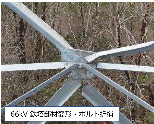
66kV 鉄塔主材変形
